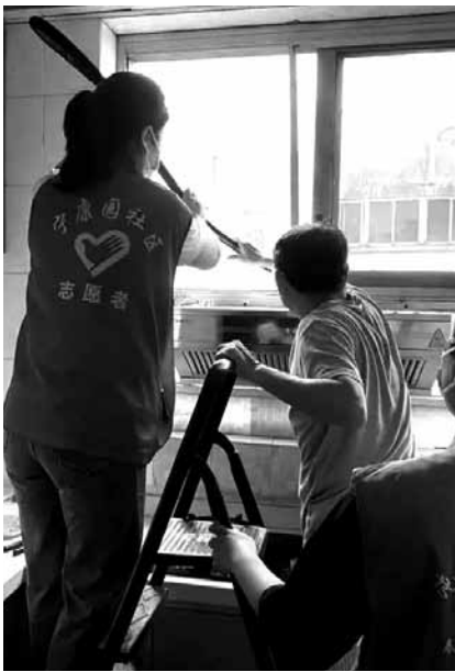
拆掉隐患管道
