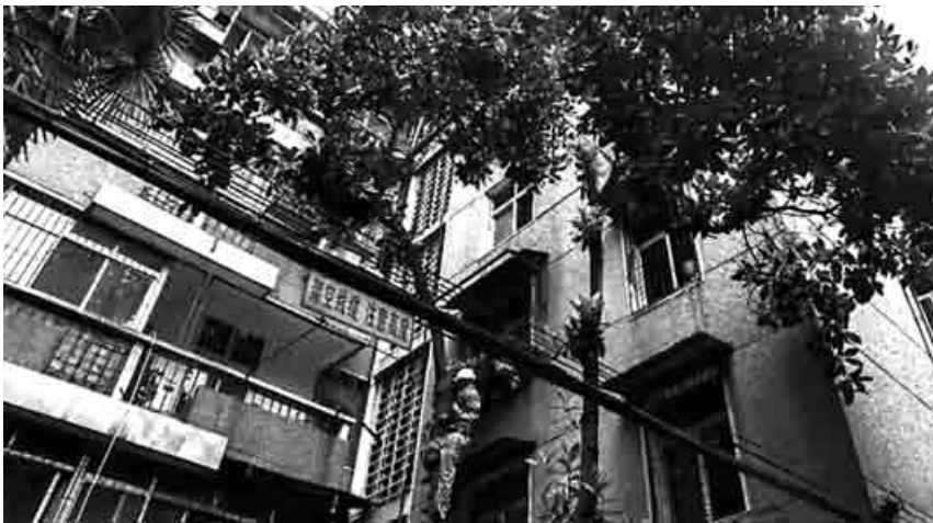
▲树枝接近居民楼影响正常生活
