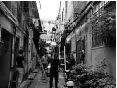
▲社区工作人员正在维修、增设晾晒绳
